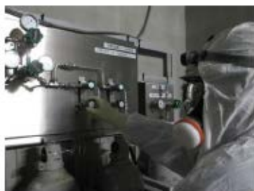
原子炉補機冷却水サージタンク加圧操作(タイベック+全面マスク)
