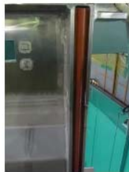
ゲートパッキンの装着状況
