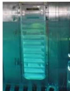
ゲートの設置状況
