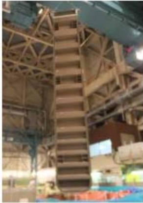
ゲート吊上げ作業 (写真は2号機)
