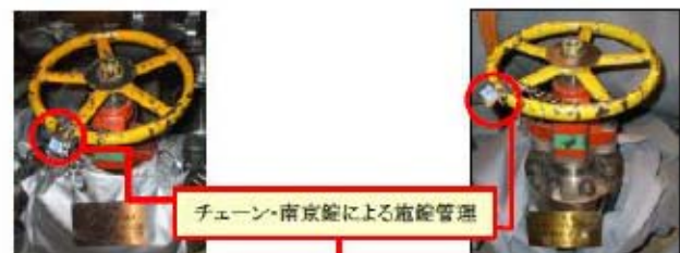
原子炉再循環系ドレンライン 【原子炉再循環ポンプ(A) 入口管第一ドレン弁 (B32-F503AX)】 原子炉再循環系ドレンライン 【原子炉再循環ポンプ(B) 入口管第一ドレン弁 (B32-F503BX)】
