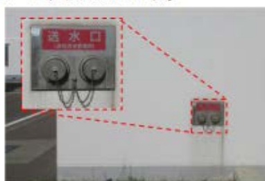
図-1 連結送水口設置状況
