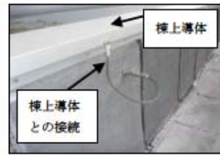
循環水ポンプ建屋
