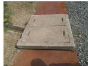
コンクリート板
