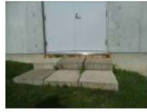
コンクリート板
