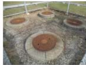
マンホール蓋
