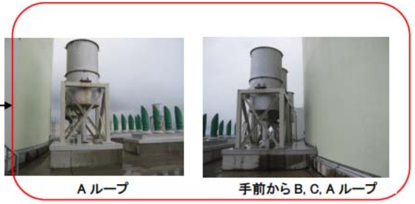
図 3 主蒸気逃がし弁消音器の設置状況
