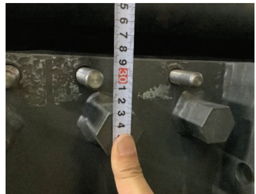
図 6.1.5-12(3) ゴムジョイント設置状況 (枠間距離計測)
