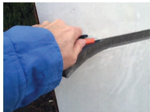
シリコーン材の切り取り状況
