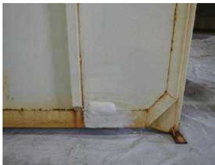
パテ埋め補修箇所
