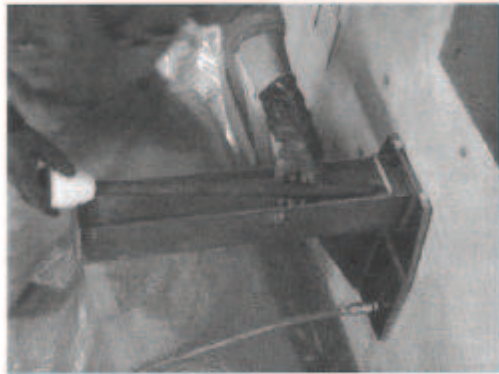
「セラミックキャップパー (CCb)」の挿入
