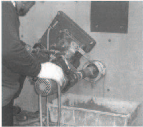
RC 部材への削孔
