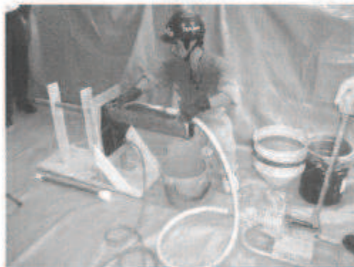
グラウトの充てん状況
