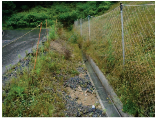
図 5-2 盛土斜面の表面排水溝 写真
