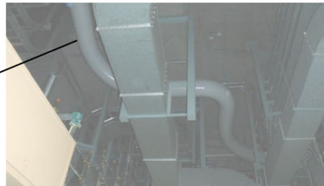
高所敷設箇所
