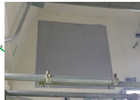
閉止板設置状況
