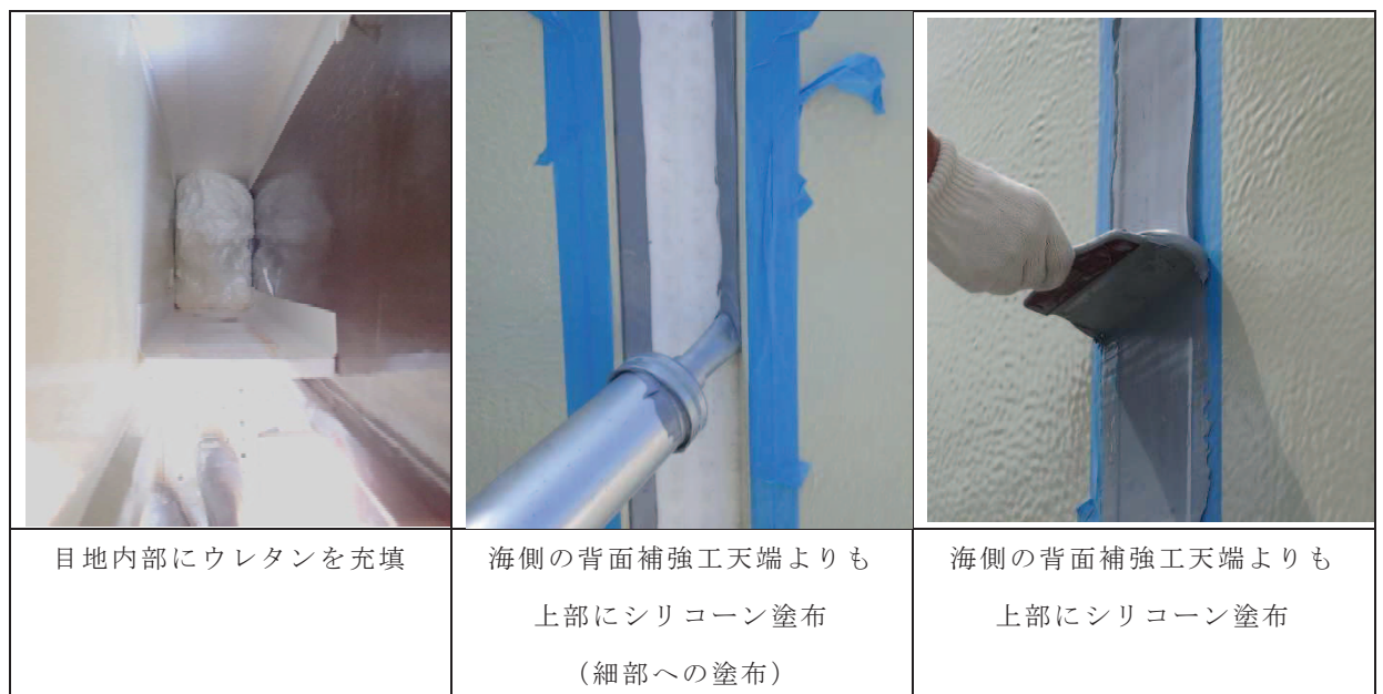
図 6.1.5-38(1) ウレタンシリコーン目地の施工状況
