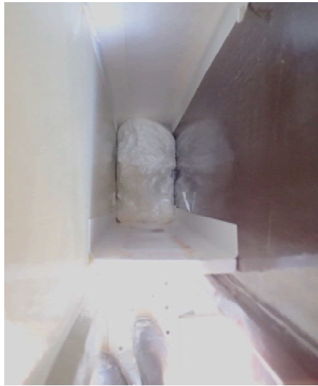
図3 目地内部でのウレタンの発泡状況
