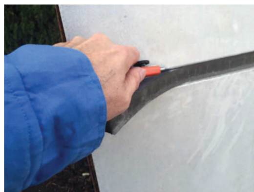
シリコーン材の切り取り状況
