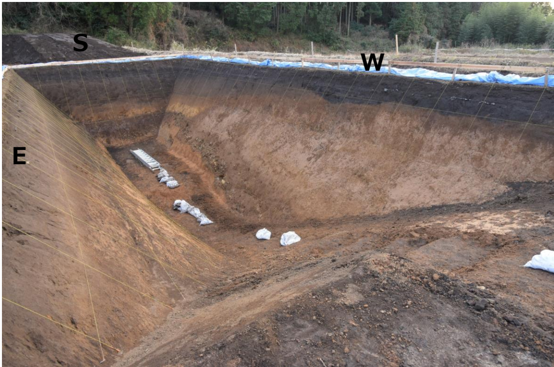
図 2.3.5 上陳東トレンチ完成時状況
