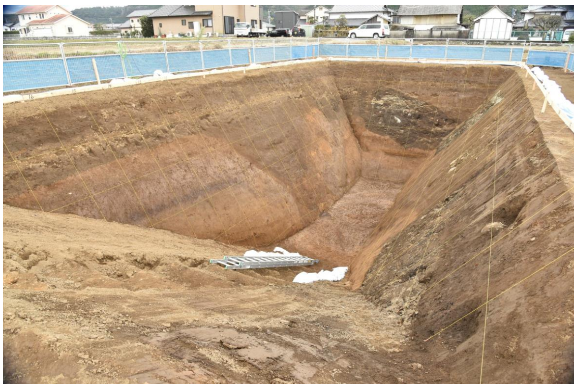
図 2.3.31 下町トレンチ完成時状況
