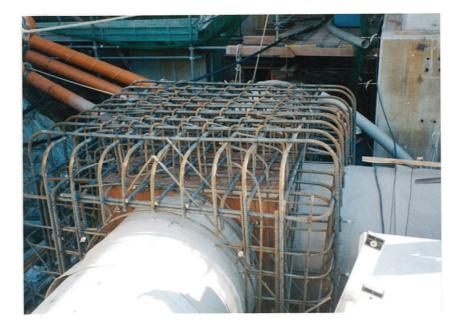
図 3-9 接続桝(D-3)の配筋図(上)及び配筋状況(下)
