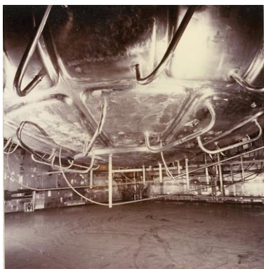
高放射性廃液貯槽(V34) 下部
