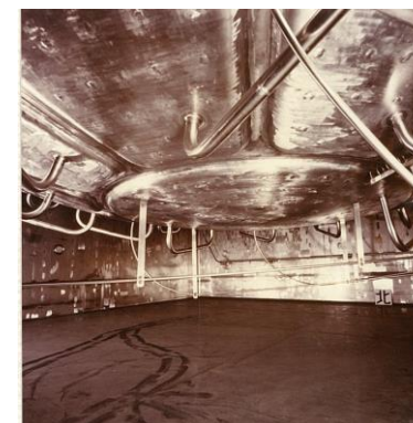
高放射性廃液貯槽 (V32) 下部
