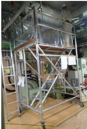
セル内へのケーブル挿入作業
