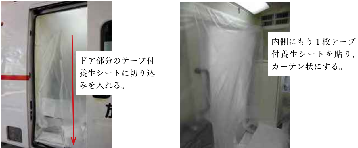
図 8. ドア部分の養生
