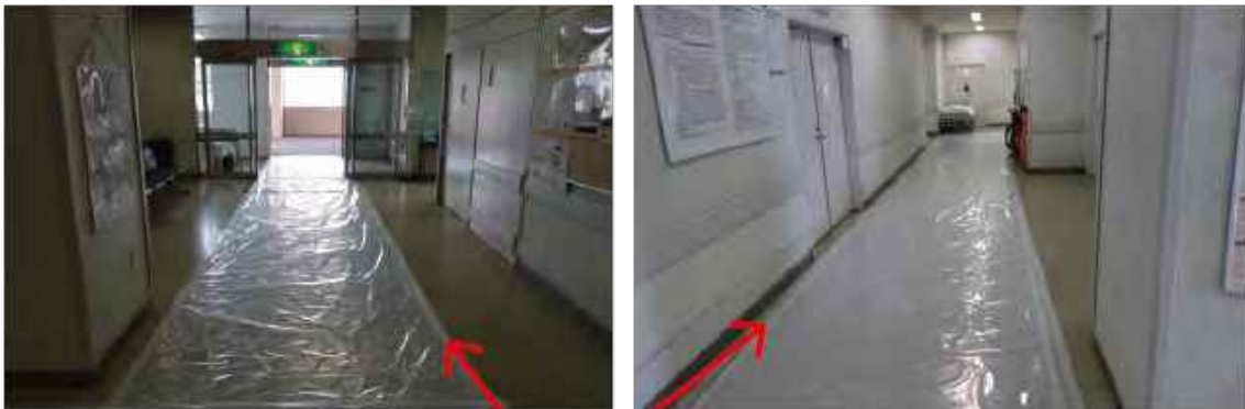
シートの縁はテープで床に隙間なく貼付する。 ビニールシートの下に放射性物質が入り込まないようにする。
