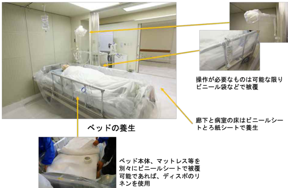
図4 病室の養生（例）
