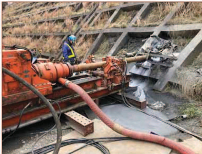
図 8-4 (1) ドレーン（鋼管）試験施工状況
