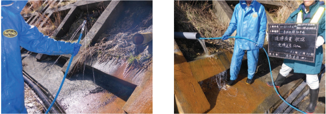
図 9-7 洗淨工（鋼管）の実施状況
