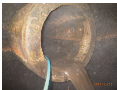
図9-13 ヒューム管洗浄状況
