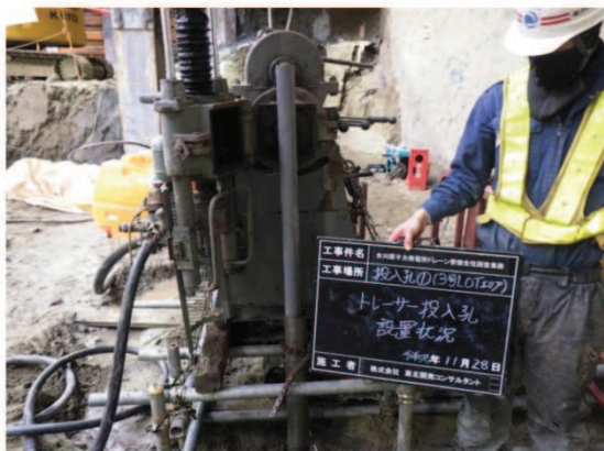
(a) 投入孔設置状況（塩ビ管挿入）
