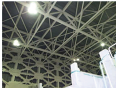
③原子炉建屋原子炉棟 3 階天井
