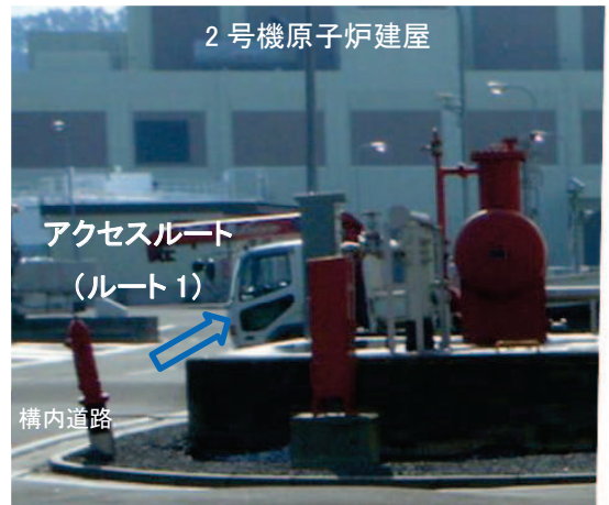
写真 C:地震後の状況【平成 23 年 3 月 12 日撮影】
