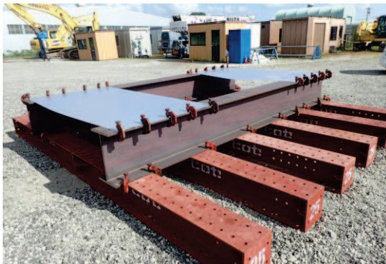
写真1 模擬屋根設置
