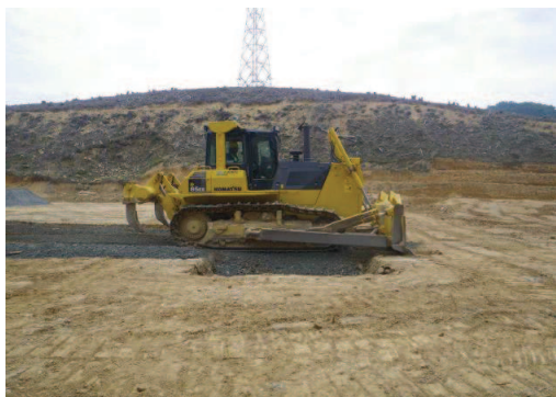
写真3 碎石運搬・埋め戻し・転圧状況
