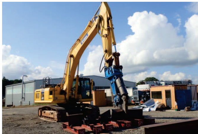
図 11-8 模擬電線及び模擬鋼材切断実証試験の状況
