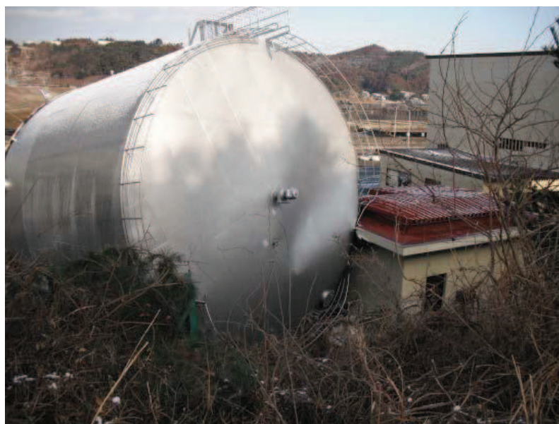
写真 4.2-1(9) 敷地内で確認された東北地方太平洋沖地震に伴う津波の漂流物 (0. P. +2.5m に設置されていた第1号機補助ボイラー用の重油貯蔵タンク)
