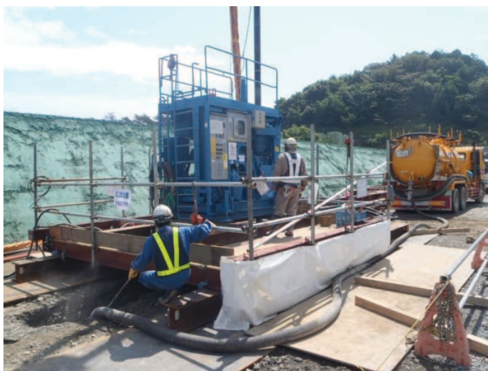
図 6.4-3 施工状況写真
