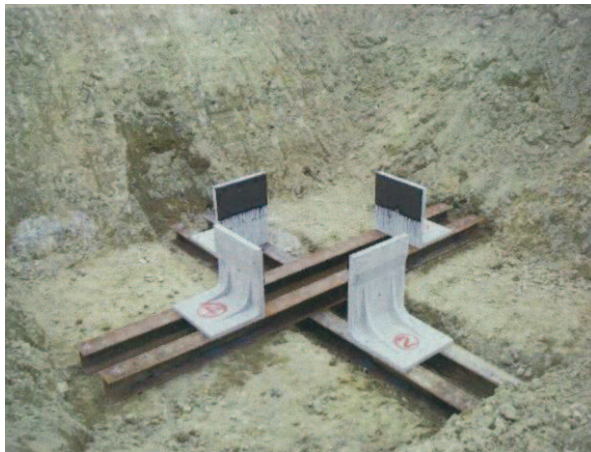
図 6.4-16 L字擁壁設置状況
