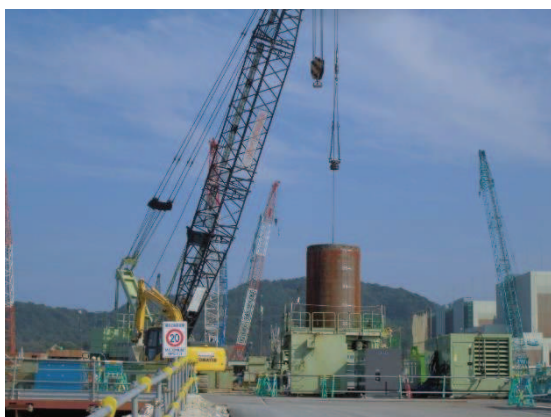
(オールケーシング工法による掘削)
