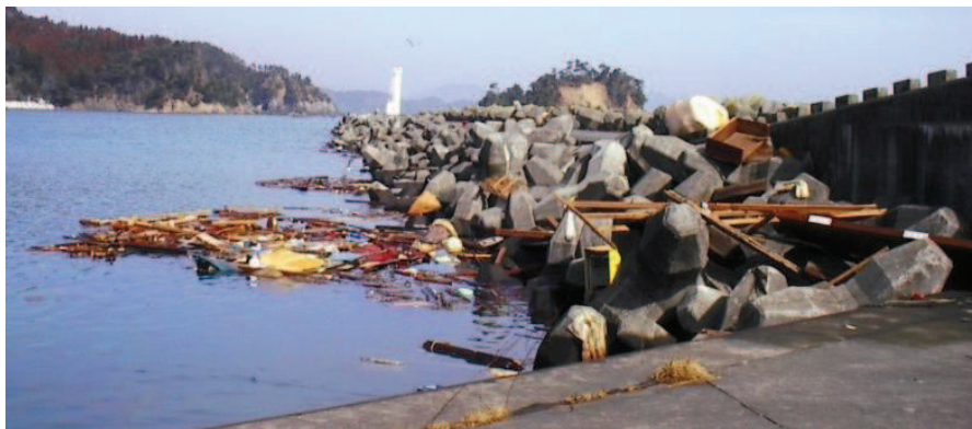
写真 4.2-1(3) 敷地内で確認された東北地方太平洋沖地震に伴う津波の漂流物 (東防波堤の漂流物状況 (平成 23 年 3 月 14 日撮影))
