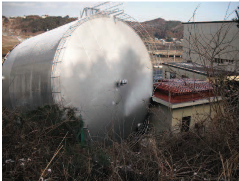
写真 4.2-1(9) 敷地内で確認された東北地方太平洋沖地震に伴う津波の漂流物 (O. P. +2.5m に設置されていた第 1 号機補助ボイラー用の重油貯蔵タンク)
