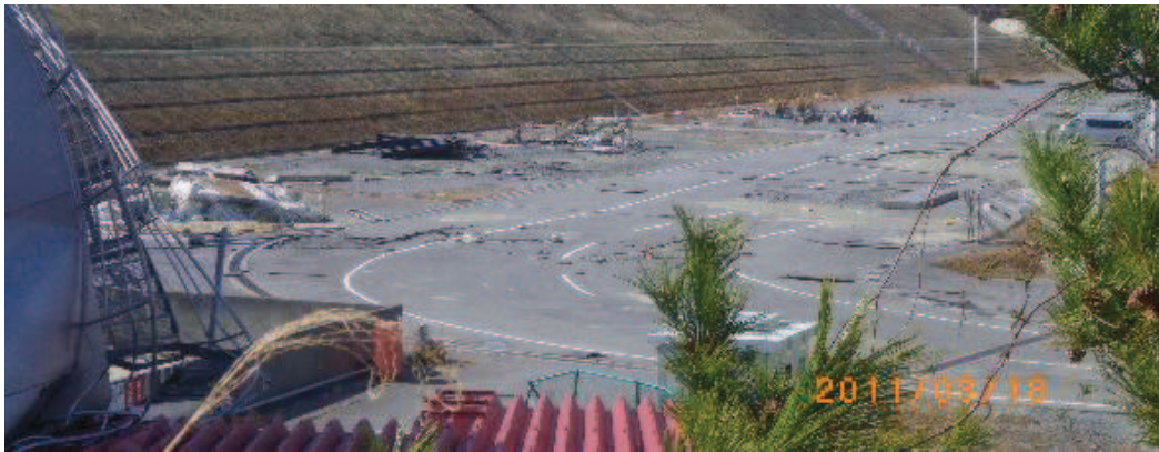
写真 4.2-1(2) 敷地内で確認された東北地方太平洋沖地震に伴う津波の漂流物 (岸壁全体の漂流物状況 (平成 23 年 3 月 18 日撮影))
