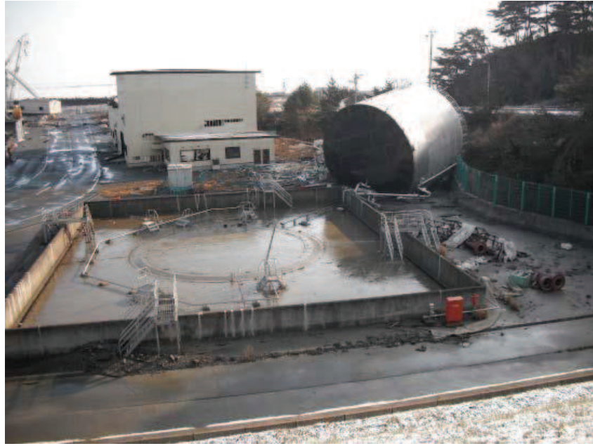
写真 4.2-1(8) 敷地内で確認された東北地方太平洋沖地震に伴う津波の漂流物 (O. P. +2.5m に設置されていた第 1 号機補助ボイラー用の重油貯蔵タンク)
