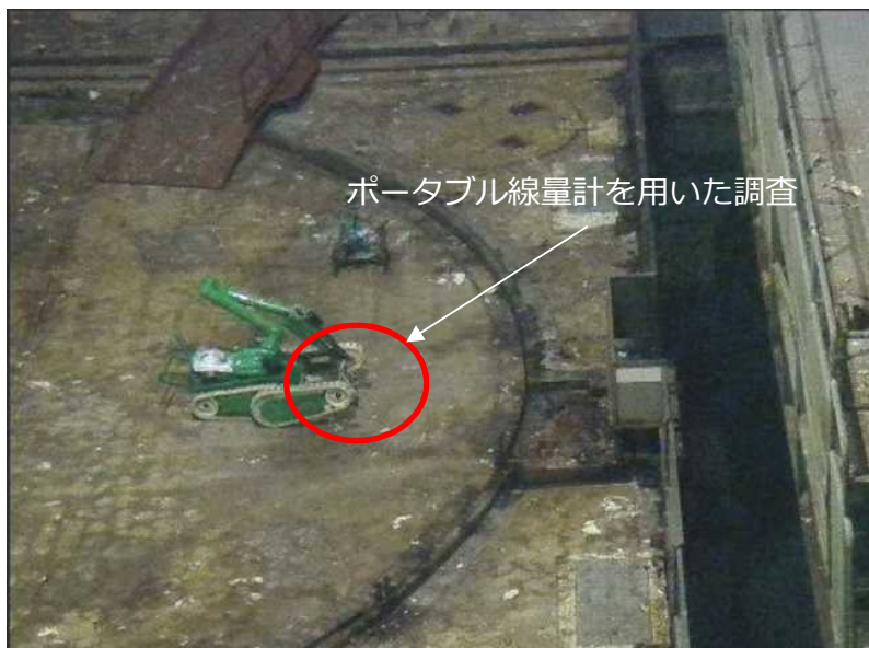
測定点⑩における床面測定状況
