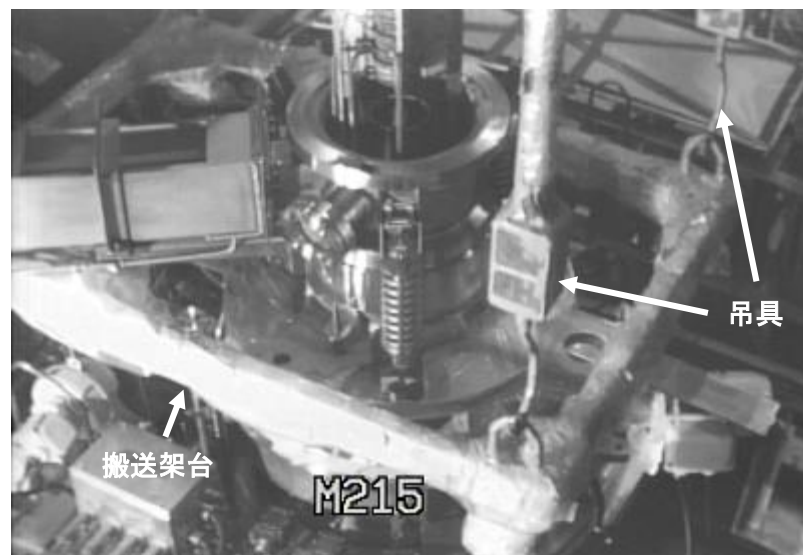
取外した既設結合装置の固化セル内移動の状況
