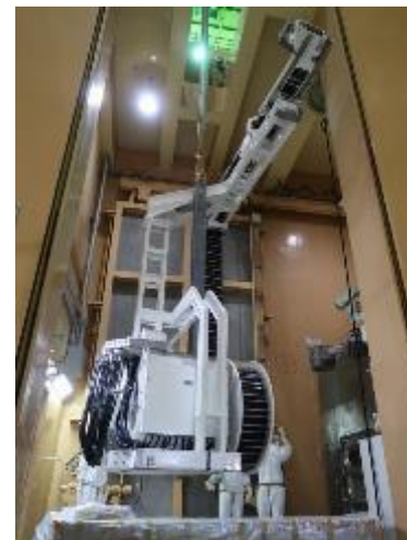
③新規走行ケーブルリール組立完了後、除染セルへの搬入
