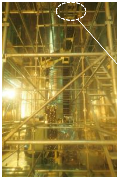
② 既設走行ケーブルリールとの取り付け位置確認 (3次元計測) (除染セル)
