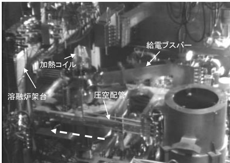
台車にて溶融炉下部に新規結合装置を移動中の状況
