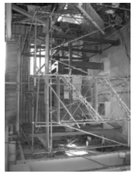
溶融炉架台の設置
