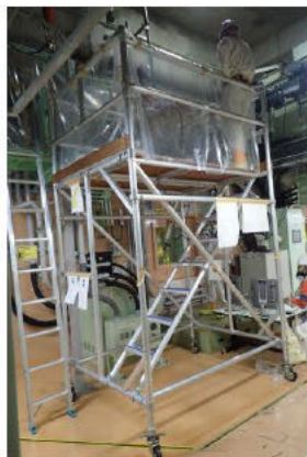
セル内へのケーブル挿入作業
