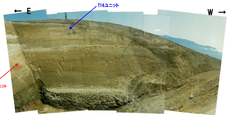
写真2 南側壁面を望む (昭和57年秋頃撮影)
