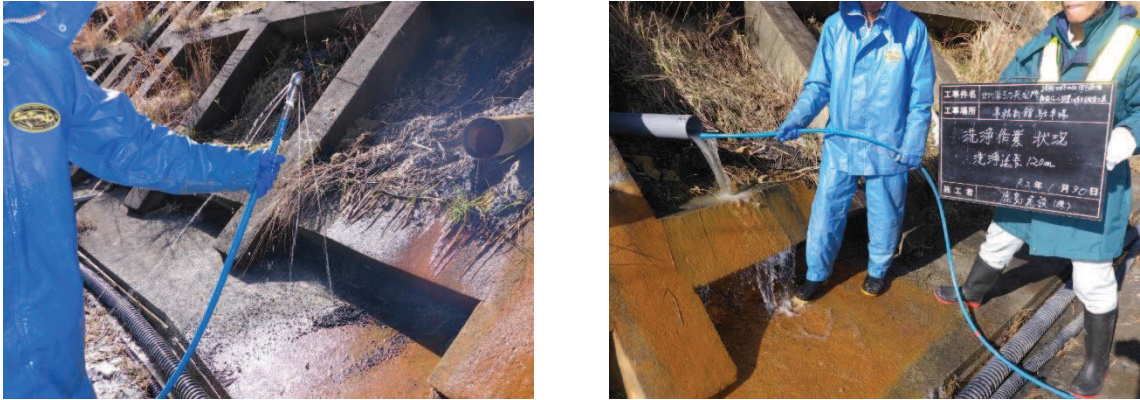
図 9-7 洗淨工（鋼管）の実施状況
