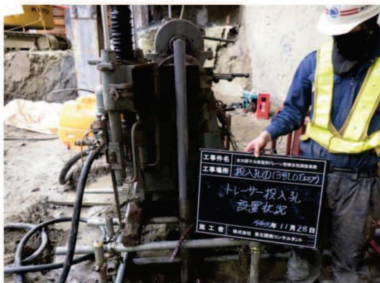
(a) 投入孔設置状況（塩ビ管挿入）
