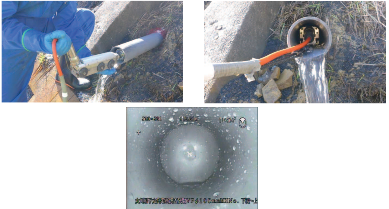
図 9-6 カメラ調査（鋼管）の実施状況
