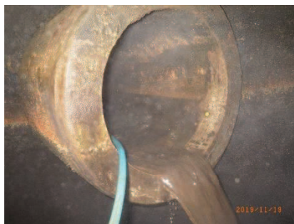
図9-13 ヒューム管洗浄状況
