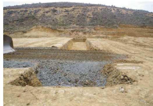
写真4 作業完了状況
