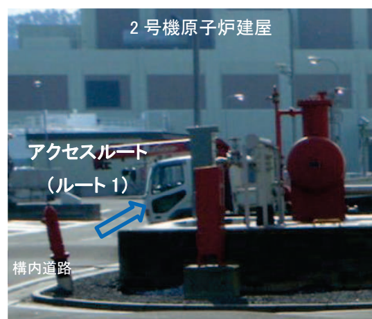
写真C:地震後の状況【平成23年3月12日撮影】
