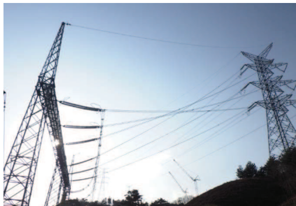
図 10.2.3-4 3号機開閉所引留鉄構の架線状況
