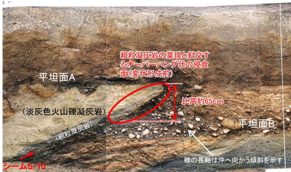
写真2 Ts-1西側法面に見られるオーバーハング状の侵食面(P.4-29参照)
