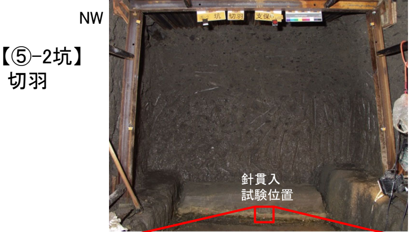
⑤-2坑 支保6+60cm 切羽写真
