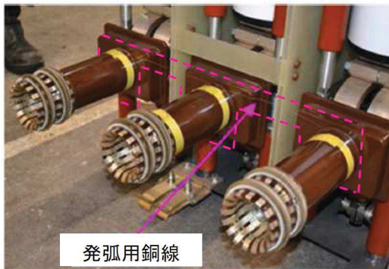
発弧線の設置状況 (遮断器 2 次側端子)
