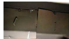
盤内仕切板の状態 (母線室-遮断器室間)
