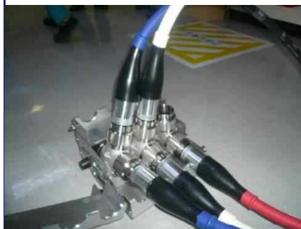
ケーブル接続
