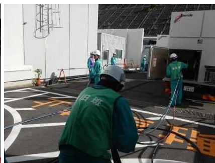
ケーブル敷設
