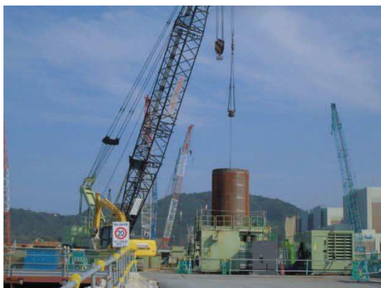
(オールケーシング工法による掘削)
