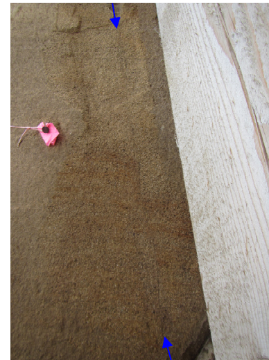
東落ち正断層(3) 拡大写真
