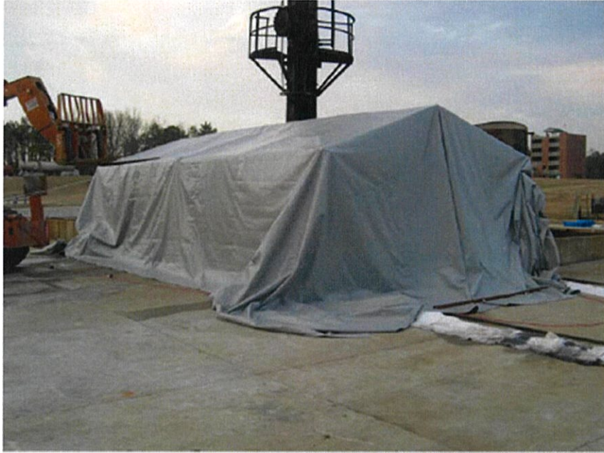
図(ロ)B 付 1- 6 夜間温度維持のためのテント
