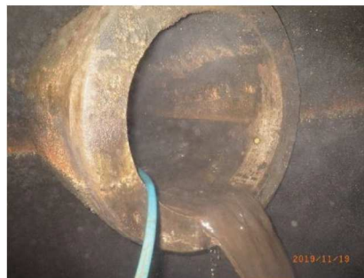
図9-13 ヒューム管洗浄状況
