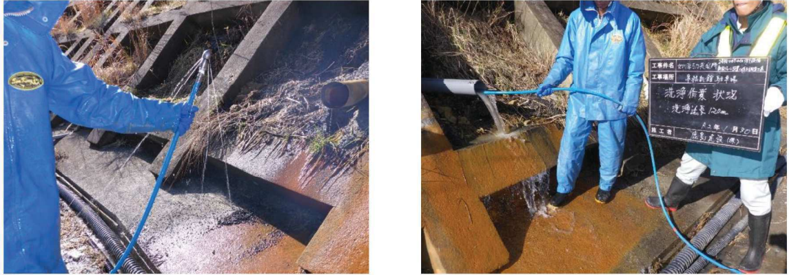
図 9-7 洗淨工（鋼管）の実施状況
