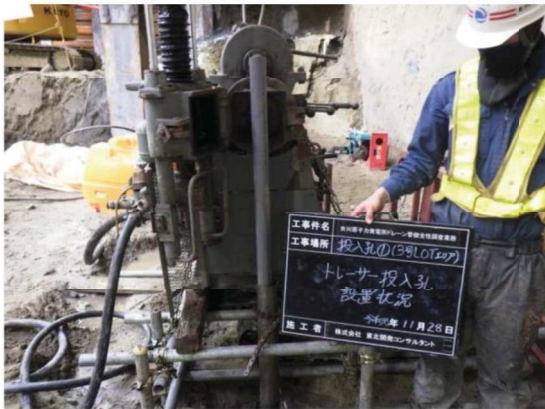
(a) 投入孔設置状況 (塩ビ管挿入)
