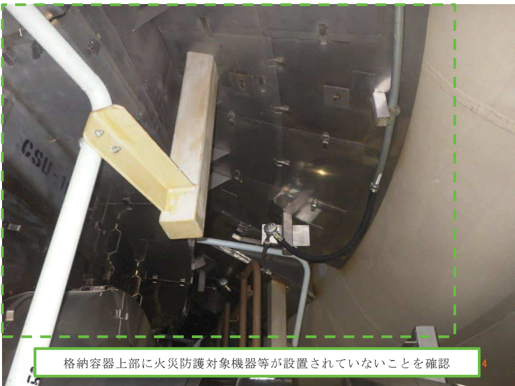
図8 原子炉格納容器上部
