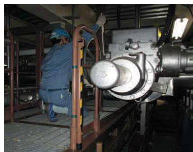
現場手動ハンドルによる開操作
