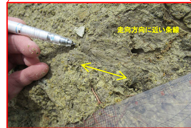
高角の変位を伴う不連続面b ・ 走向・傾斜: N59° E, 82° N ・ 走向方向に近い明瞭な条線有り(プランジ角14° N)
