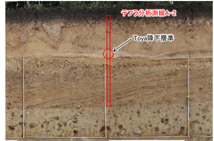
法面④詳細画像
