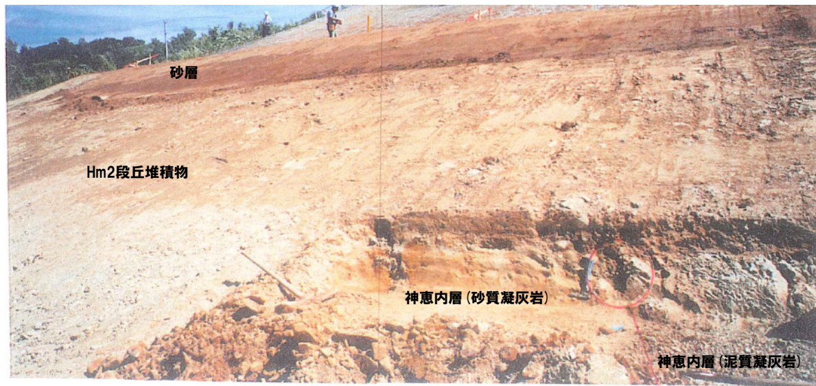
全景写真 (敷地造成工事時露頭)
