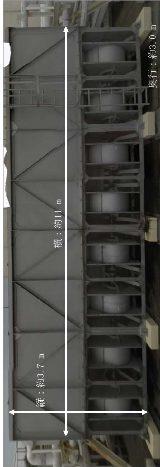
図 2 (1/2) 冷却塔概要 (高放射性廃液貯蔵場 (HAW))
