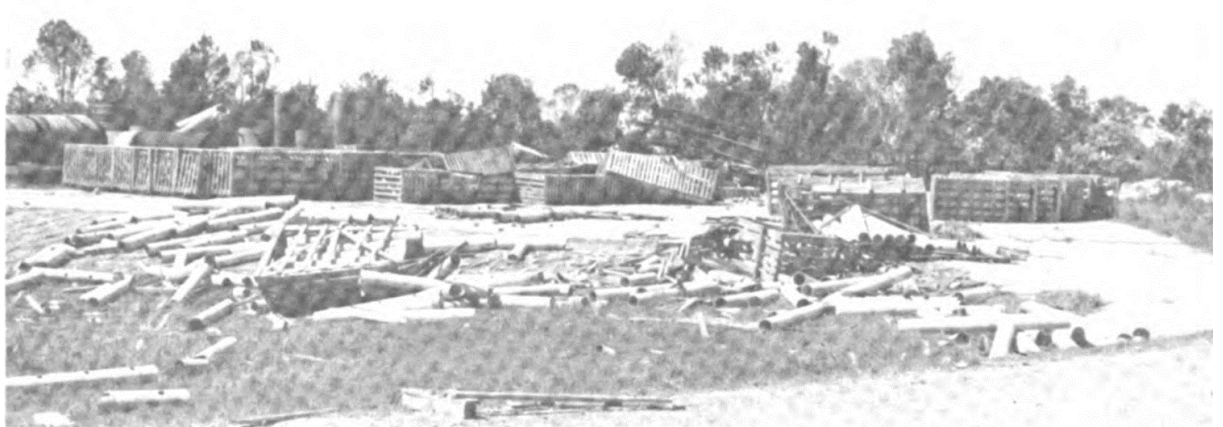
図29 Grand Gulf 原子力発電所資材置き場におけるパイプの散乱状況
