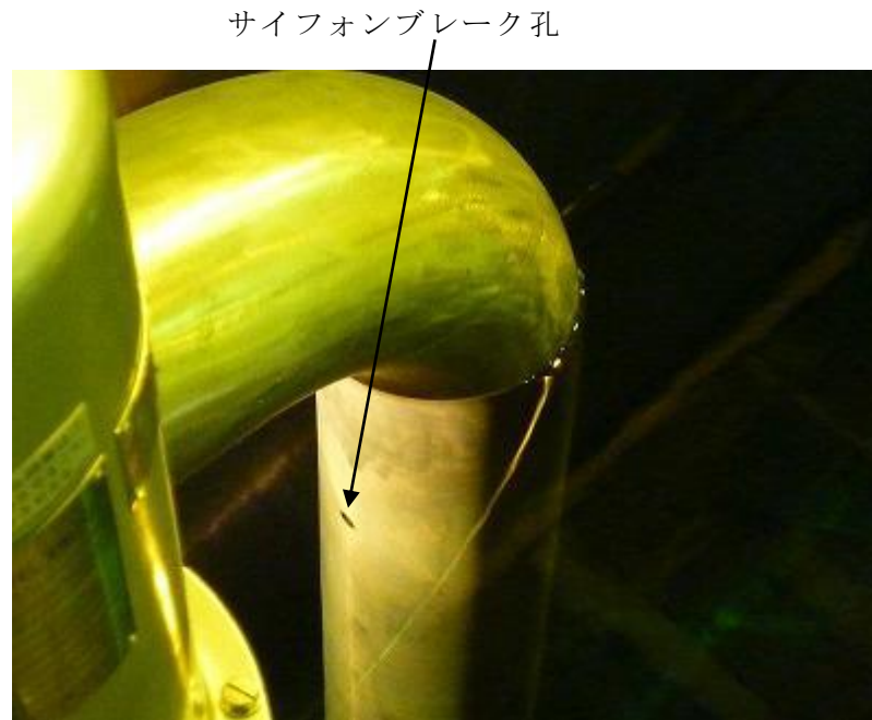
図 1-2 サイフオンブレイク孔の現場写真
