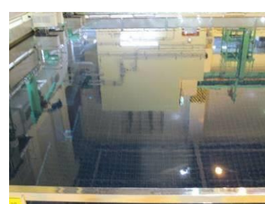
④使用済燃料貯蔵プール 内ラック
