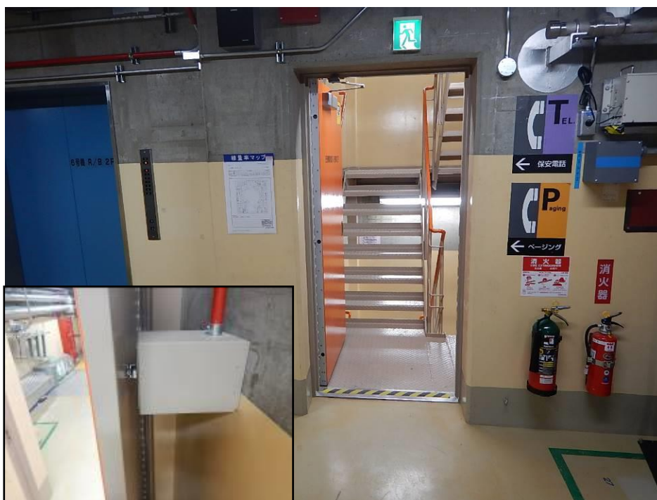
第 9.10-9 図 対策実施予定箇所示例 (落下防止板の撤去)
