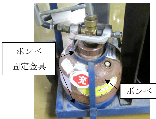
【技能訓練施設技能訓練棟】 アセチレンポンベ
