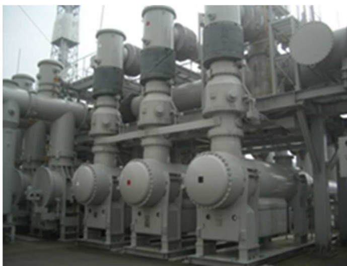
(ガス絶縁開閉装置イメージ)
