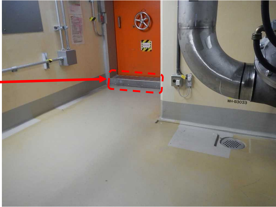
図 4 - 1 漏えい油の拡大の防止対策の例
