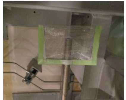
(フラッシングの様子)
